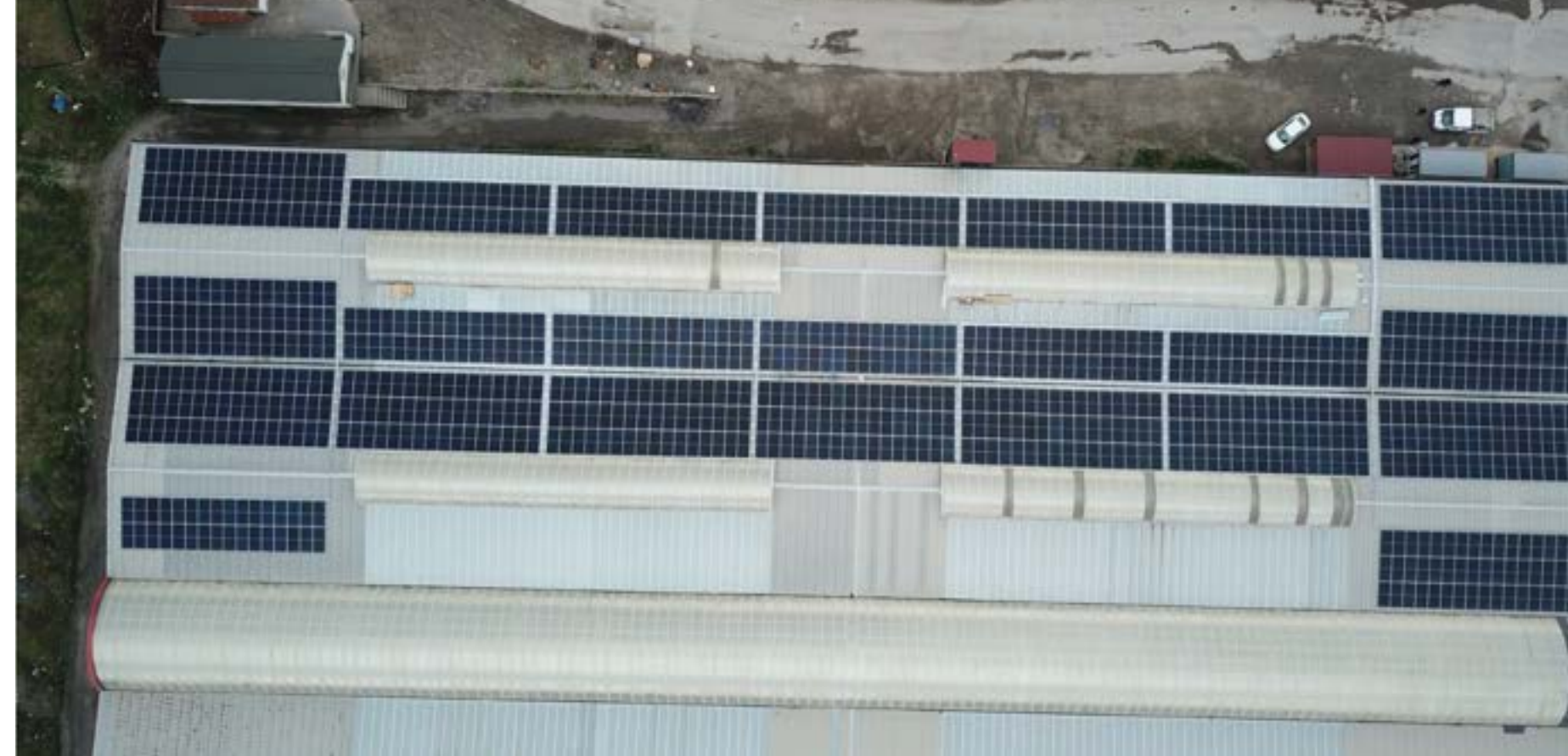
ALAPLI / 576 KWp / 450 KWe / ZONGULDAK / 2026
